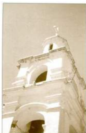
■ Torreón de la iglesia de la Santa Cruz / (DI)
