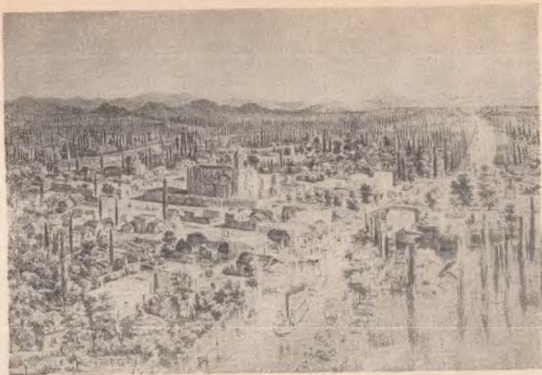
Los barcos de vapor navegaban por los canales de la Plaza del Volador a Xochimilco.
